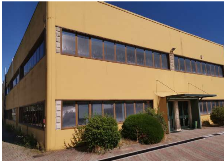
Figura 1: Sede operativa Via Spagna Il Traversa, 3/3A - 87036 Rende (CS)
